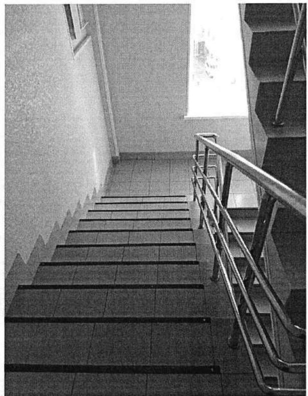
Фото 13. МЛШ, Лестница (внутри здания)
