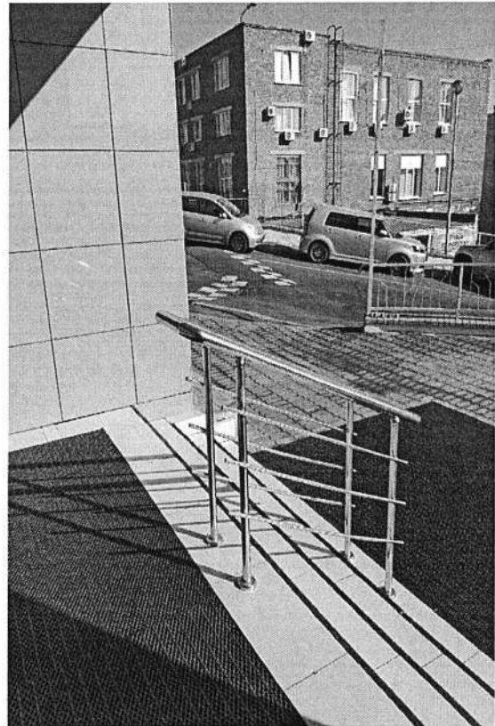
Фото 4 МЛШ. Лестница (наружная)
