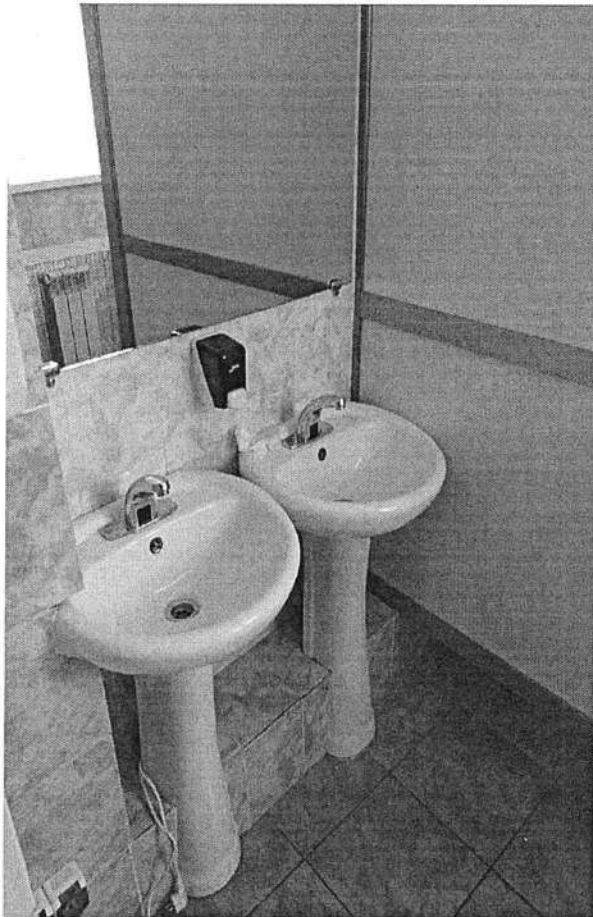
Фото 34. МЛШ. Туалетная комната
