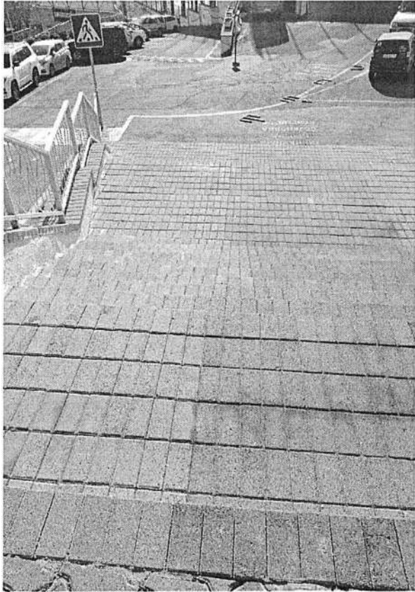
Фото 5. МЛШ. Лестница (наружная) на площадке перед входом
