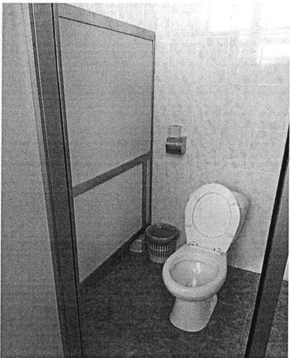
Фото 36. МЛШ. туалетная комната.
