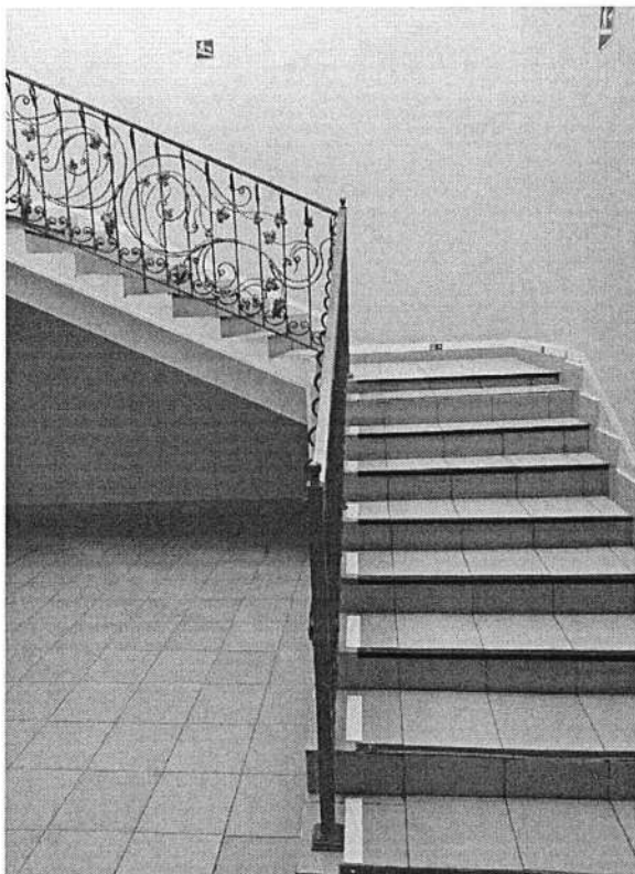
Фото 12. МЛШ. Лестница (внутри здания)
